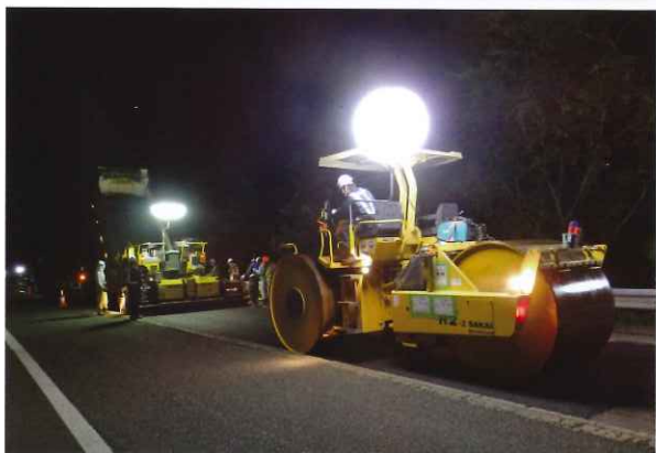
舗装補修工事
