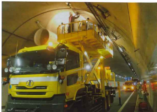
トンネル設備の点検・清掃
