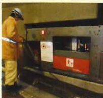
泡消火栓点検
